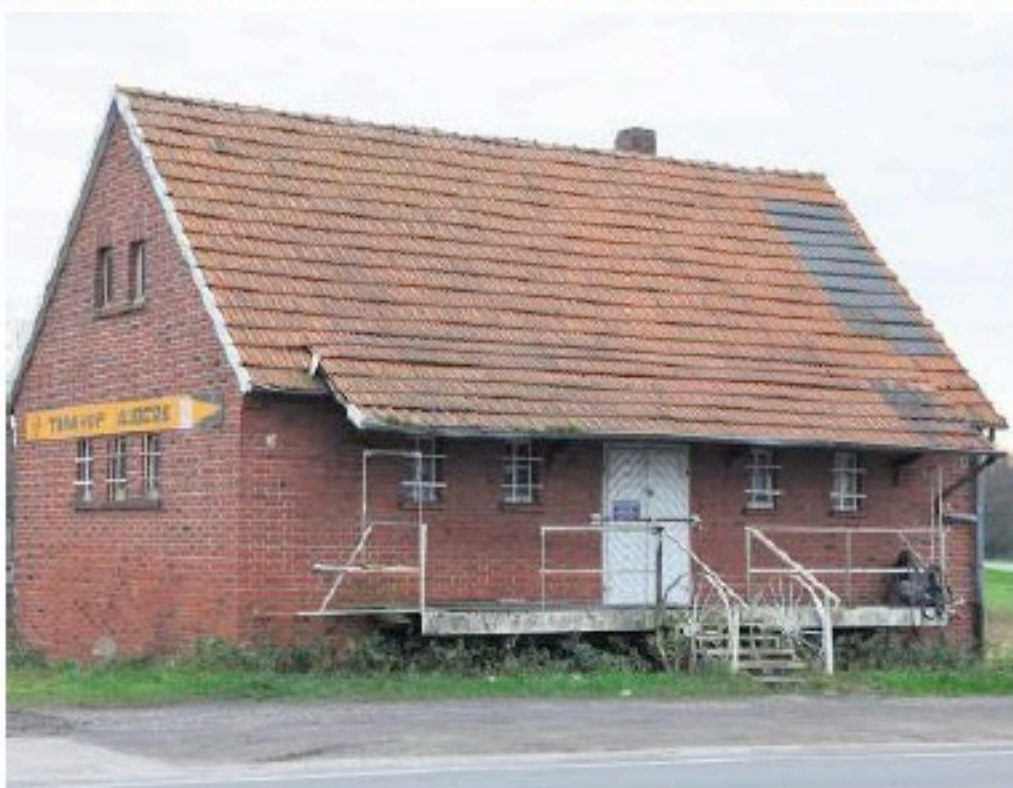
Das ehemalige Gebäude der landwirtschaftlichen Genossenschaft am Ortseingang von Oeding
